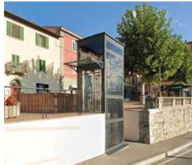
L'ascensore che collega la piazza del municipio al sottopasso ferroviario
