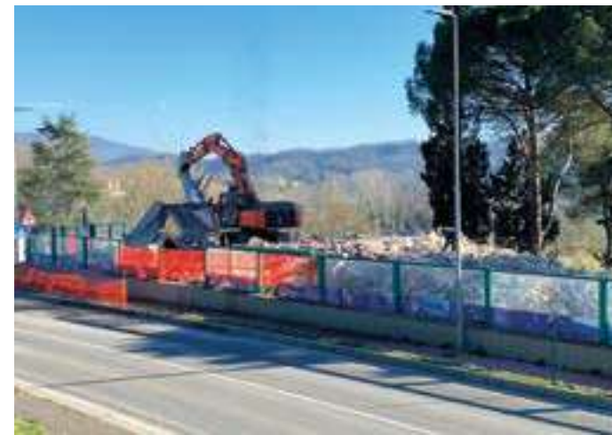
Lavori in corso al vecchio asilo nido di Prulli
